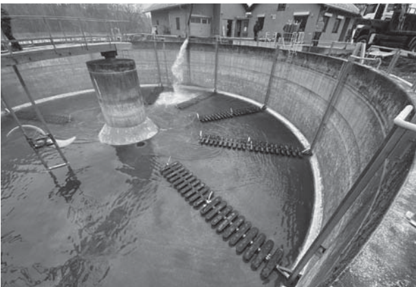
Befüllung des zweiten Klärbeckens zur Strudelprobe
